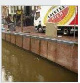
Poser les Grip Blocks est très simple, parce qu'ils sont légers et faciles à scier et percer. Le haut et le bas des Grip Blocks KLP® sont spécialement profilés pour être scellé en maçonnerie. Dans des constructions neuves, les Grip Blocks KLP® peuvent être directement inclus dans le quai. Une rainure de 13 cm de hauteur et d'au moins 8 cm de profondeur devra être faite dans le quai sur des projets de rénovation. Les Grip Blocks seront alors boulonnés sur le support.
