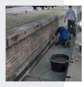
Le plastique KLP® se dilate avec la chaleur et se rétréci avec le froid. Selon la longueur de l'installation, nous vous recommandons de prévoir des joint de dilatation d'au moins 1 cm. Ces joints sont ensuite comblés avec du mastic.
